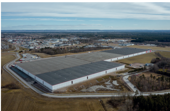
Pohjois-Euroopan suurin varasto sijaitsee Skarassa. Sen kokoa on hiljattain laajennettu 178 000 neliometriin.
