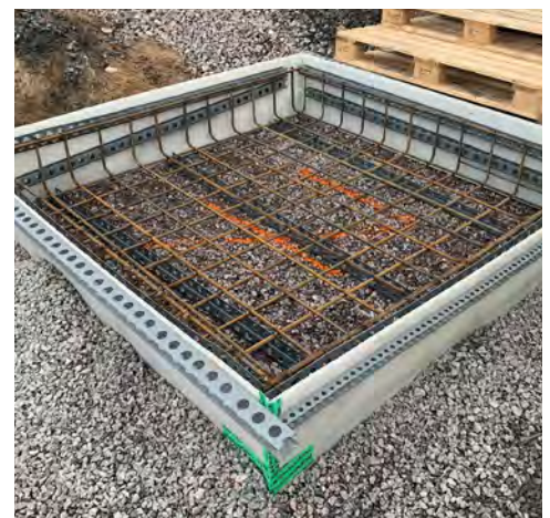
Att motfylla direkt och lämna formen i marken. En dröm för byggaren men en mardröm för miljön. Nedbrytningstid ca 450 år - fortfarande med risk för efterlämnade partiklar av mikroplast.
